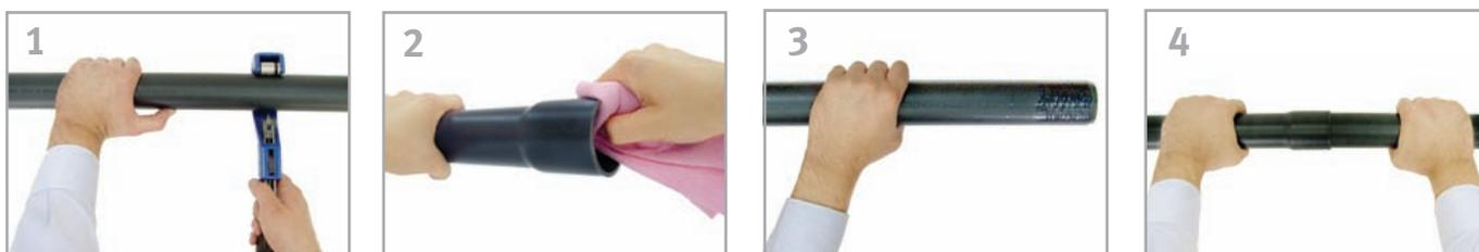
Группу разъёмных соединений составляют соединения компенсационного типа, выполняемые с помощью уплотнительных колец. Герметичность и надежность уплотнения в компенсационных соединениях обеспечивается: деформацией резинового кольца, его радиальным сжатием между раструбом и трубой.
